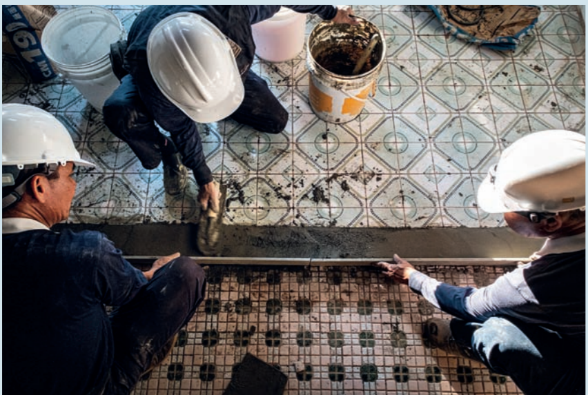
一戶隔間牆倒塌，志工拆除後，抹上水泥修補凹陷處。
