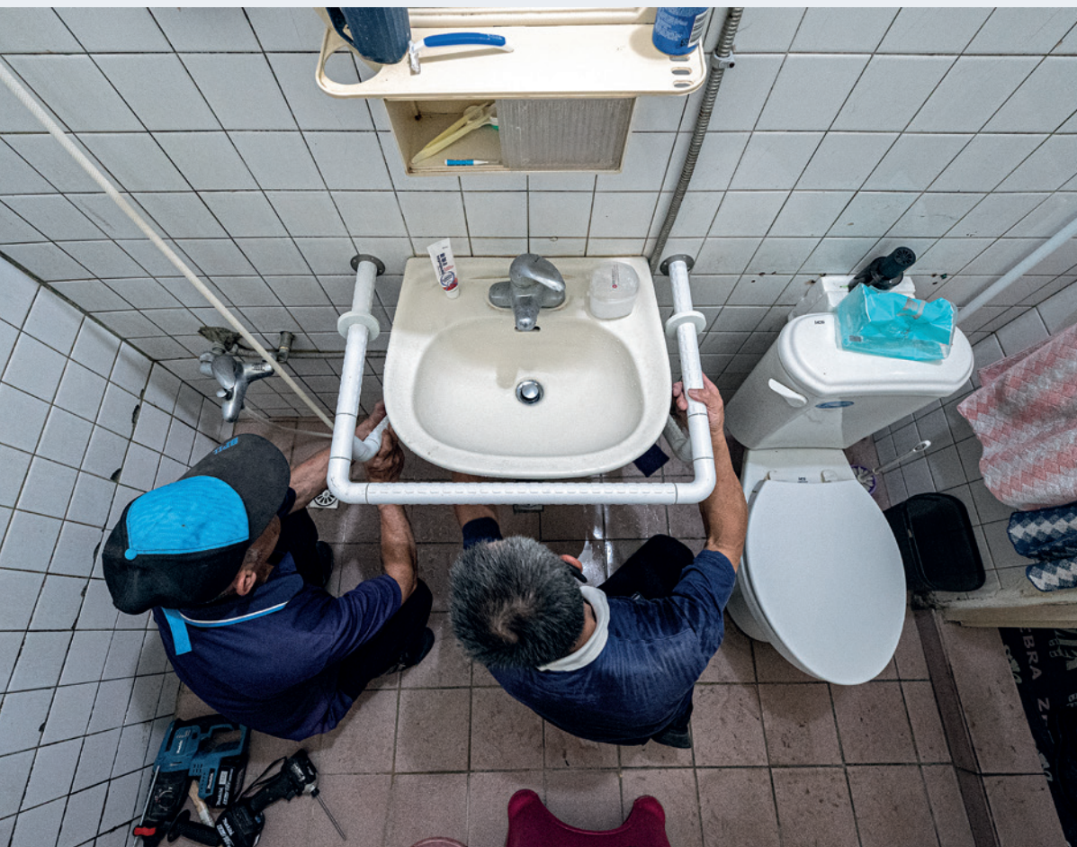
陶器の洗面台では体重を支えられないため、修繕ボランティアはその周りに、W字型の手すりを取り付けて高齢者がしっかりと掴むことができるようにした。(撮影・蕭耀華)
