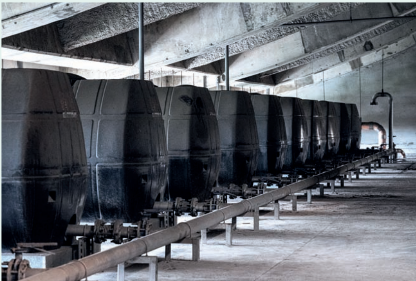
臺中慈濟醫院在頂樓屋簷下設大型集水槽，因高溫天數變多，空調耗水量也隨之增加，回收雨水可節約自來水用量及抽水馬達用電量。
